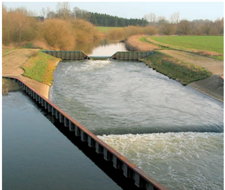
Ende der Erlaubnisstrecke Hase I der NWA. Die Hase kurz vor Unterquerung des Mittellandkanals.
